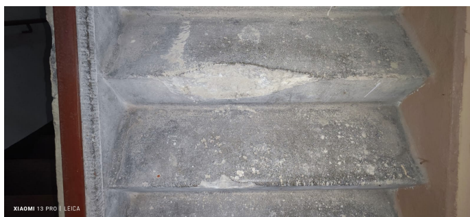
Fot. 5. Widoczne uszkodzenia biegów schodowych klatki schodowej od strony elewacji wschodniej.
